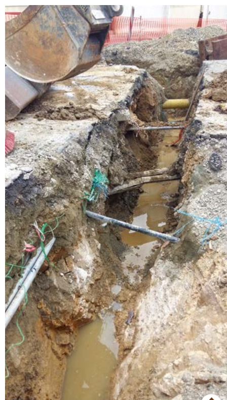
↑ Sous la route...
